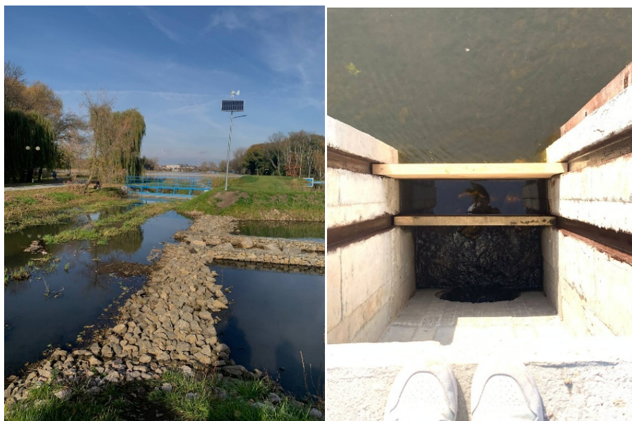
Рисунок 3 – Системы очистки талых вод в Польше
